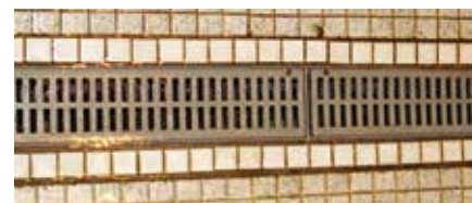
MINI CHANNEL DRAINAGE IN DECK
